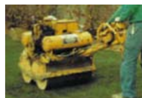
Compattazione del riempimento con rullo
