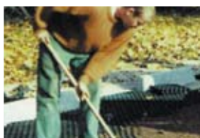
Riempimento delle celle alveolari e livellamento
