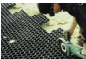
Taglio dei pannelli
