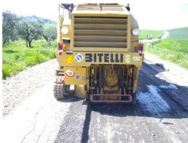
Fresatura della pavimentazione ammalorata
